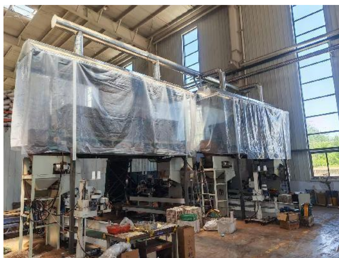
图 3-4 包装机落料口集气罩
