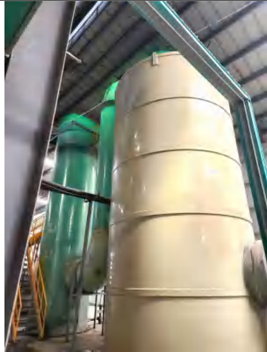
图 3-4 废气洗涤塔
