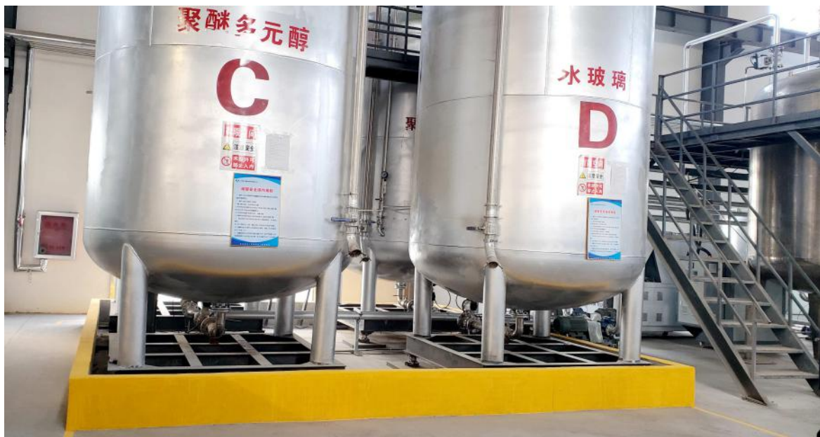
图 3-4 罐区围堰
