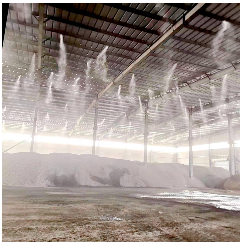
图 3-1 水雾喷淋降尘系统
