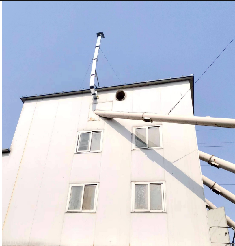
图 3-2 西侧搅拌机除尘器排气筒 DA002
