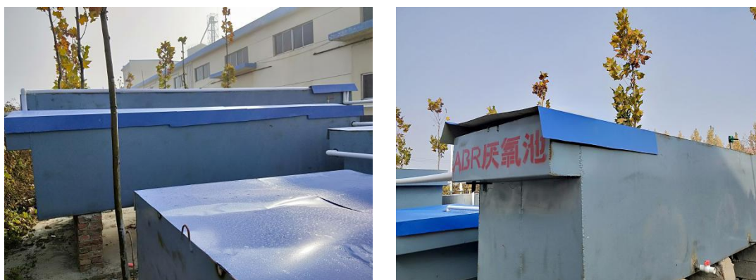
图 4-1 污水处理站产臭单元加盖
